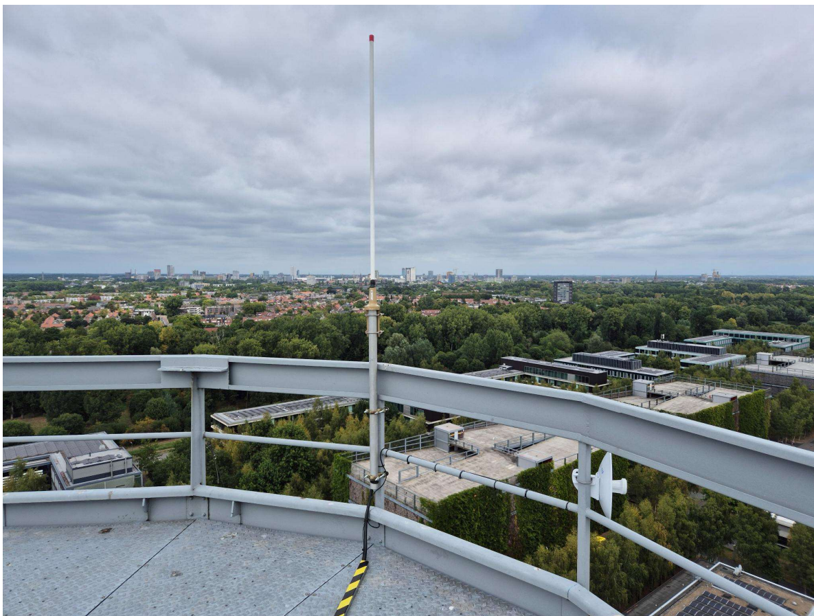
Foto: de repeater en de bijbehorende antenne op de High Tech Campus in Eindhoven
